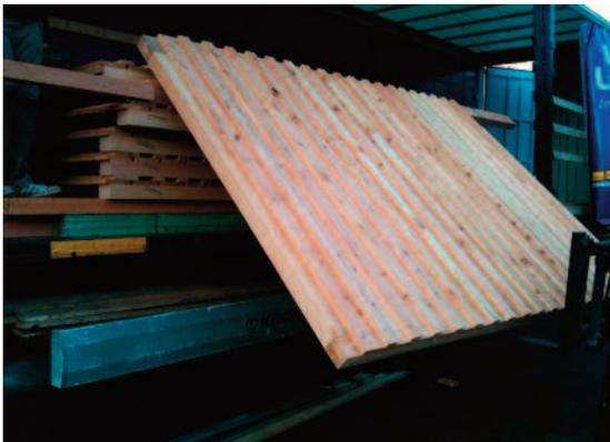
Zwei Personen schieben ein Wandelement so weit aus dem Trailer bis sie Übergewicht bekommt. Zwei Personen, die rechts und links neben der Wand stehen, nehmen die Wand an und sorgen dafür, dass diese relativ sanft zu Boden gleitet.
