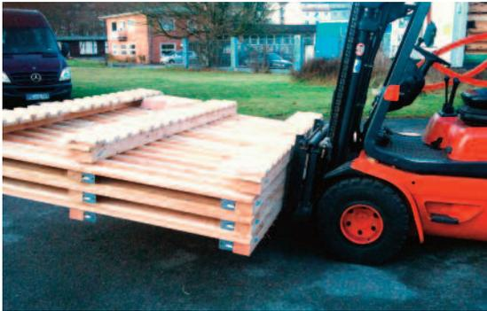
Je nach Tragfähigkeit des Staplers lassen sich auch 4 - 6 Wände auf einmal entladen. Erfahrungsgemäß sind 4 Wände optimal.
