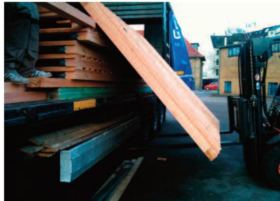
Lassen Sie die Wand an der Seite stehen und schieben Sie auf die gleiche Weise die anderen Wände herunter. Jede Wand kann dann mit zwei Personen neben den Trailer gelegt werden. Der weitere Transport der Wandelemente zur Baustelle muss nach der trailerentladung gemacht werden, denn die Spedition hat in der regel nur wenig Zeit für die Entladung eingeplant.
